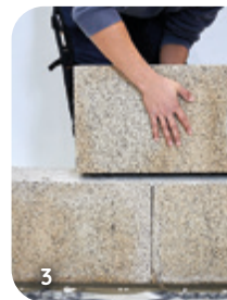
Abb. 3: Hanfsteine aus lokal und schnell nachwachsenden Fasern, Mineralien, Naturkalk und Wasser. © isohemp
