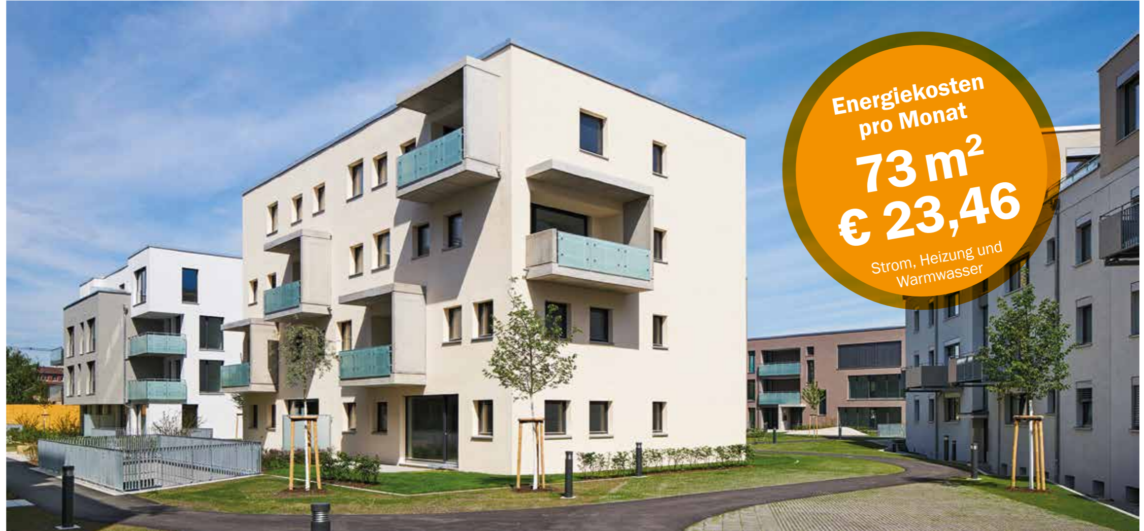
CO 2 -freies Quartier in Mannheim, Stadtteil FRANKLIN, „ganz unterschiedliche Elemente, die wirklich etwas ganz Neues darstellen.“
